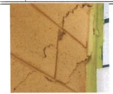
Foto 2: Paredes grietadas por sismos de peprimaria
