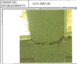
Foto 1: Columna grietada por sismo de preprimaria
