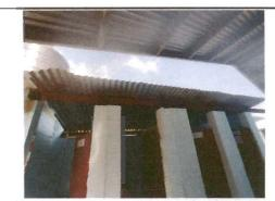
Foto 4: Cambio del techo por losa, de baños que servira de base para tinaco del agua de la cosina.
